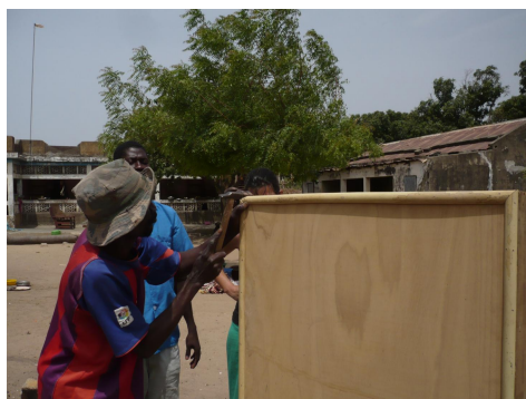
Réparation et consolidation du séchoir
