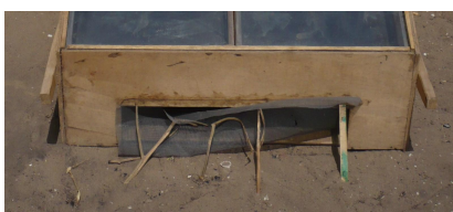
Grille (avant réparation)
